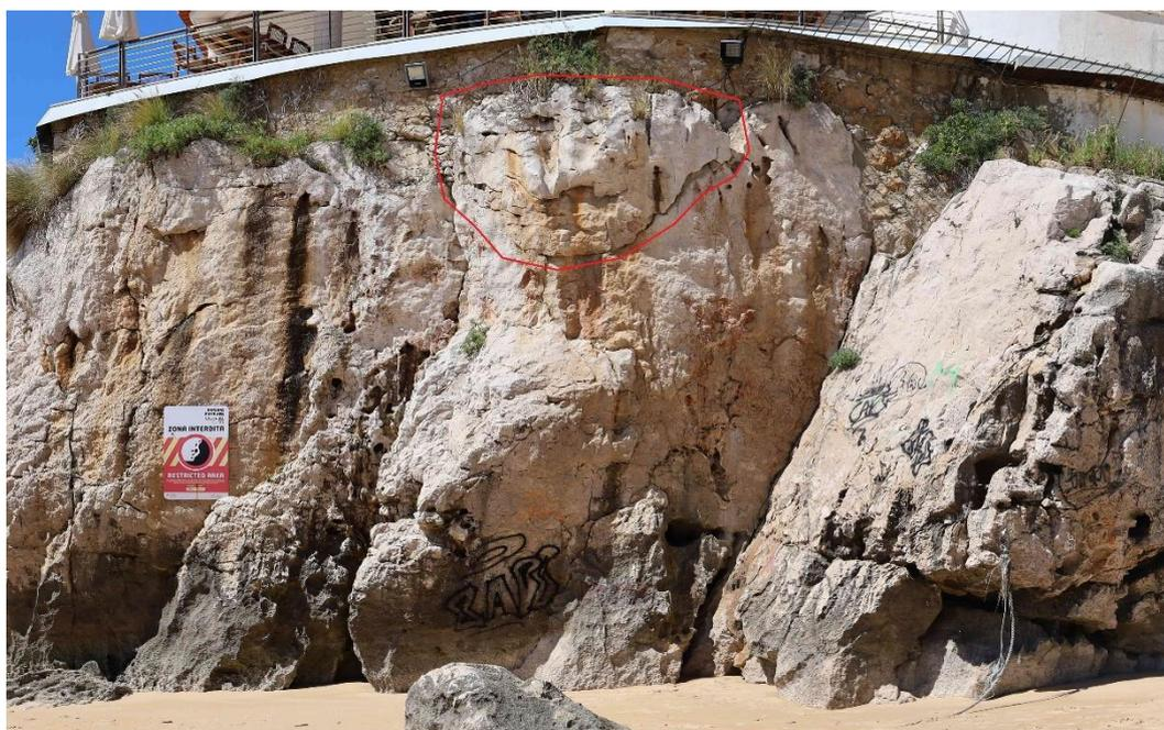
Imagem 1 – Identificação do bloco de rocha na situação de instabilidade
